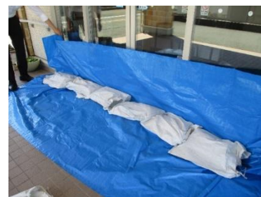
水害に備えた、水のう設置訓練の実施
