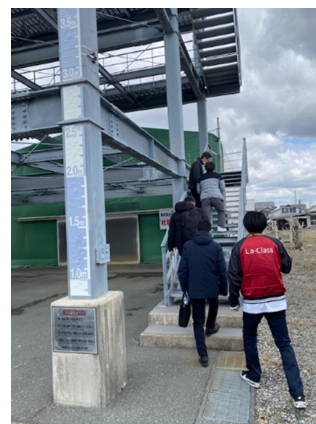
津波避難タワー訓練の実施
